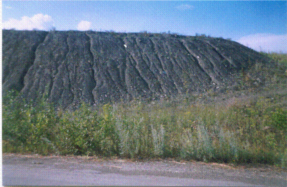
Рис. 4.1. Террасированный отвал с тридцатичетырехлетним окончанием отсыпки с плоской вершиной
