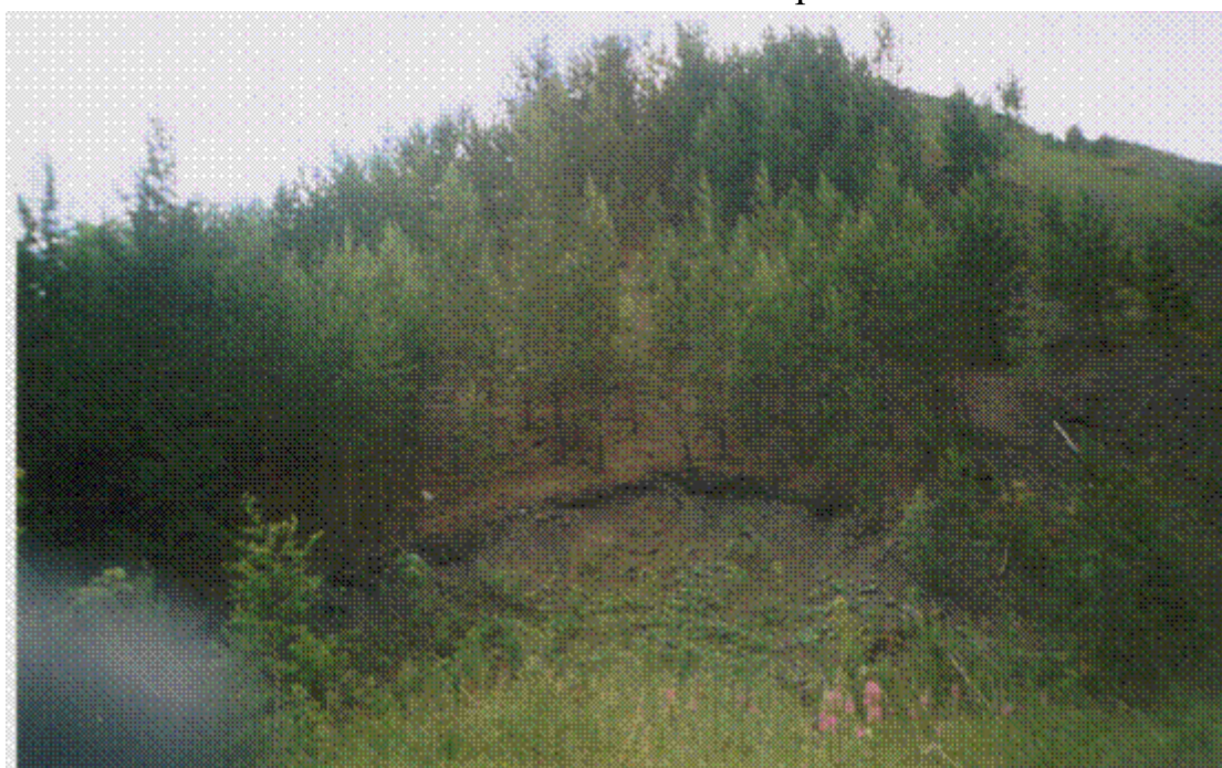
Рис. 4.2. Террасированный отвал с тридцатилетним окончанием отсыпки с плоской вершиной
