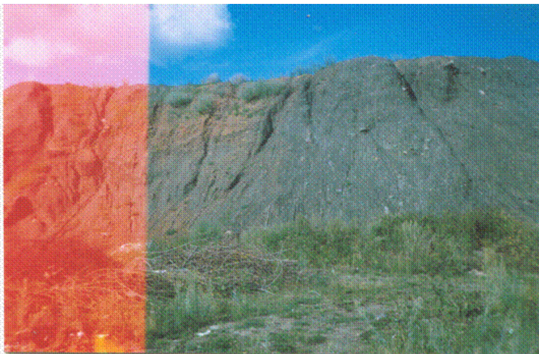
Рис. 4.2. Террасированный отвал с тридцатилетним окончанием отсыпки с плоской вершиной
